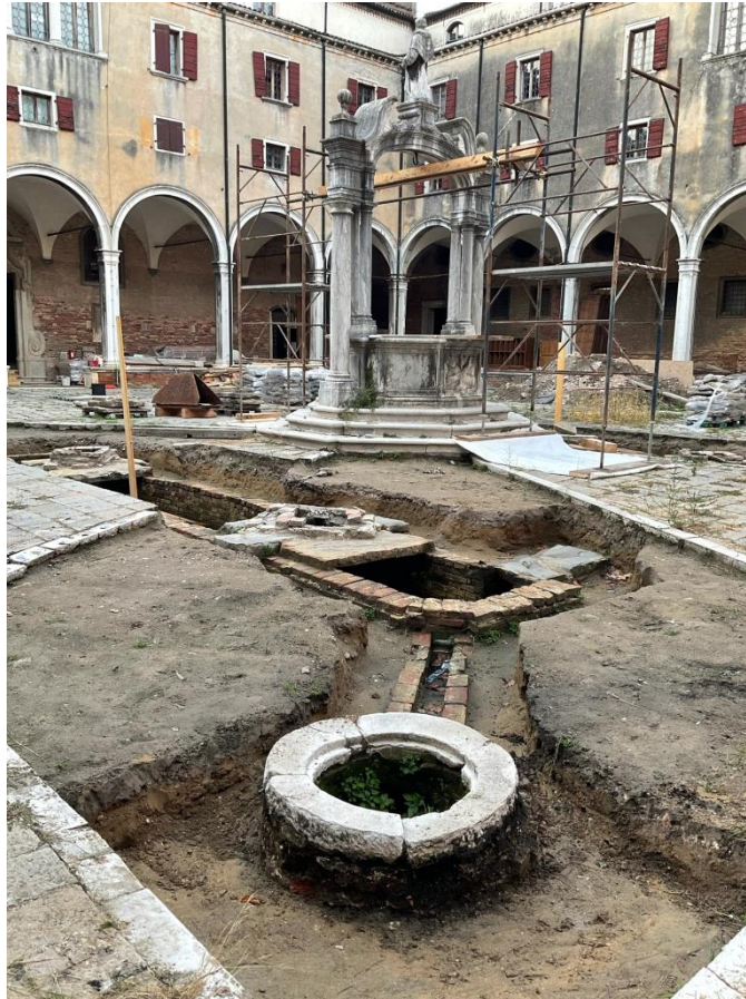
Archivio di Stato di Venezia ai Frari. Interventi di restauro nella cisterna del Chiostro di Sant'Antonio.
